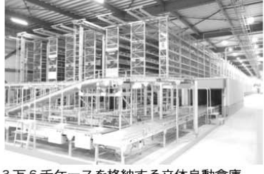
3万6千ケースを格納する立体自動倉庫
